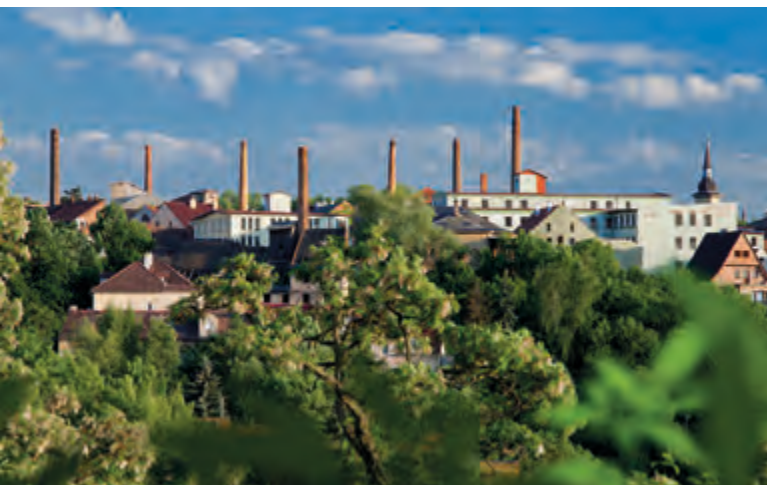
View from the south of the characteristic panorama of the Prague Suburbs in Žatec with hop processing buildings and their chimneys („forest of chimneys“), 2017 Pohled na charakteristické panorama Pražského předměstí v Žatci s chmelařskými budovami a jejich komíny („les komínů“), 2017
