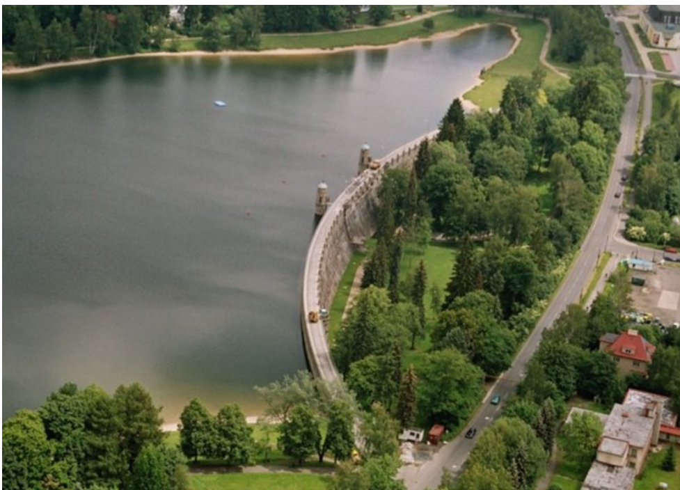
VN Mšeno - pohled na hráz
