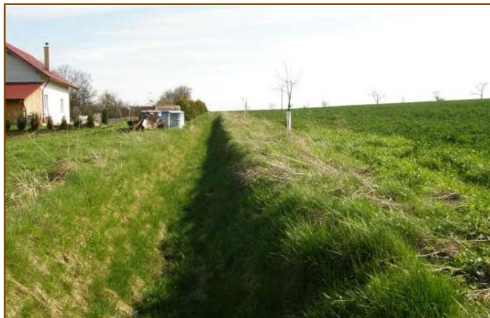
Obr. 4-17: Protierozní záchytný příkop (Rašovice u Uhliřských Janovic, foto VÚMOP, v.v.i.). Díky valu, vzniklému nad příkopem nesprávnou údržbou se voda nemůže dostat do příkopu a teče paralelně po poli.
