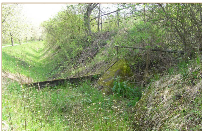
Obr. 4-32: Svodný příkop v terasovaném sadu, Starovice. Pomocí dluží je možno odtékající vodu soustřeďovat v retenční nádrži (vpravo nahoře) (foto: VÚMOP, v.v.i.)
