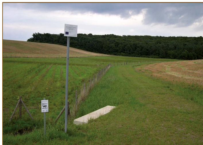
Obr. 4-20: Ochranná hrázka (Hlubočany, foto VÚMOP, v.v.i.). Na návodní straně nemá hrázka travní pás, po kterém bude stékat zadržovaná voda podél hrázky. Voda tak poteče po poli, které bude erozně poškozovat.
