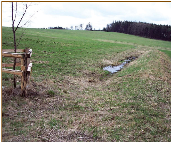
Obr. 4-18: Průleh (Milínov, foto VÚMOP, v.v.i.). Tento průleh nesplňuje díky hrázce s příliš strmými svahy základní podmínku průlehu – tedy možnost přejíždět mechanizací. Stejně tak by bylo možno ho nazvat mezí se záchytným nebo svodným prvkem nebo zemní hrázkou s příkopem. Val by mohl být osázen vegetací.
