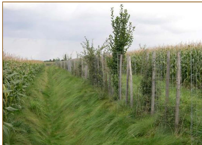
Obr. 4-25: Protierozní mez s příkopem (Heroltice u Tišnova, foto VÚMOP, v.v.i.). Tuto mez by stejně tak bylo možno označit za sběrný příkop s ochranným travním pásem a výsadbou doprovodné vegetace.
