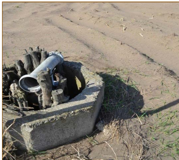
Obr. 6-5 Nefunkční závlahové systémy na jižní Moravě (foto: VÚMOP, v.v.i.)
