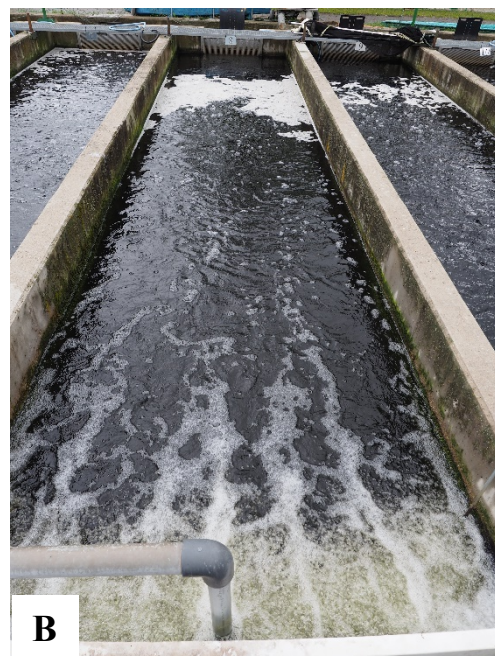
Obr. 1. Venkovní recirkulační akvakulturní systém (RAS) dánského typu (A) produkčního podniku BioFish s.r.o. s detailním pohledem na odchovnou nádrž (B).
