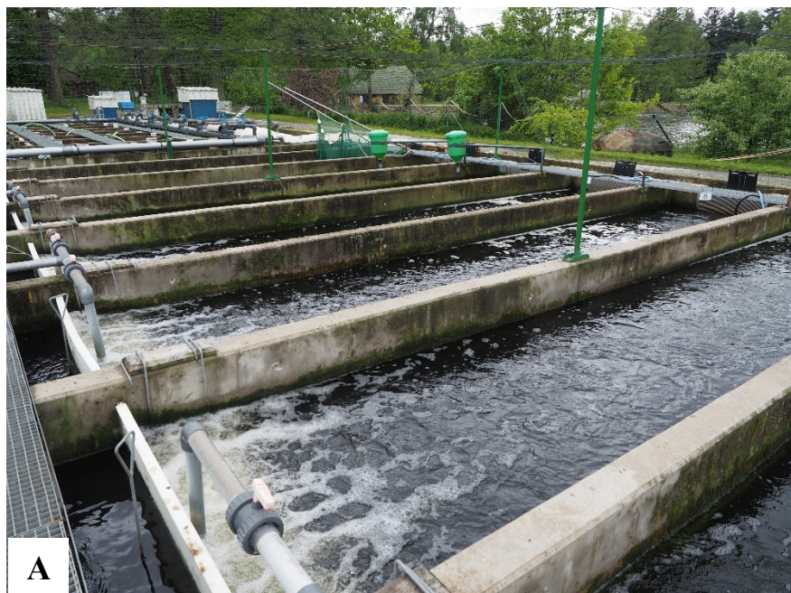
Obr. 1. Venkovní recirkulační akvakulturní systém (RAS) dánského typu (A) produkčního podniku BioFish s.r.o. s detailním pohledem na odchovnou nádrž (B).
