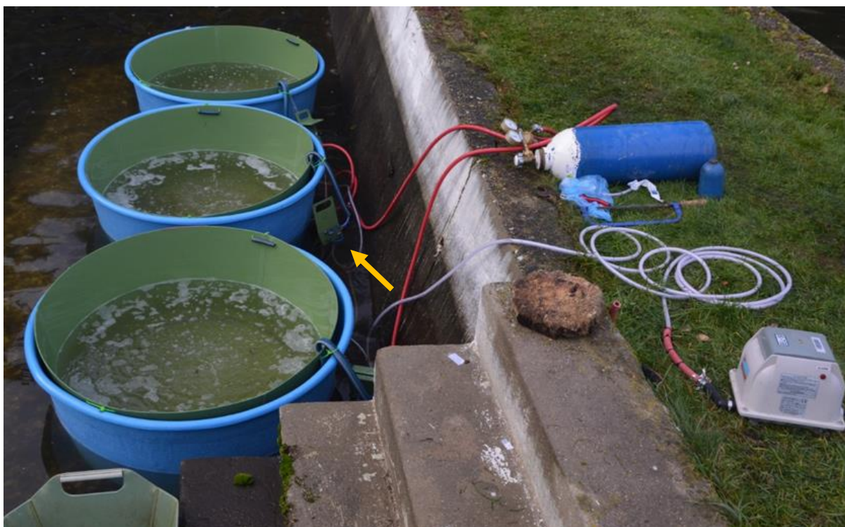
Obr. 5 Původní uspořádání rozvodu plynů s regulací průtoku kyslíku u kádě (viz. žlutá šipka), při experimentu č. 1, sádky Tábor (foto J. Regenda).
