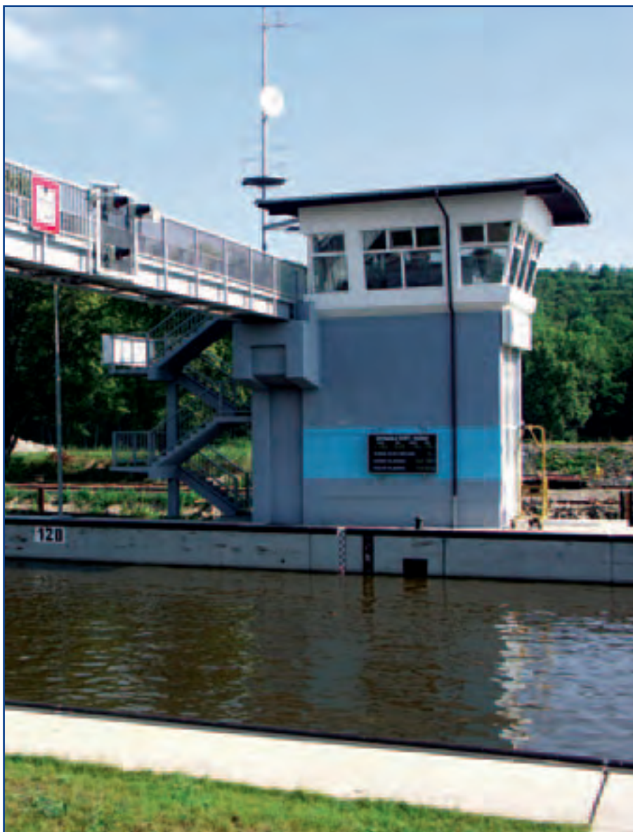
Povodí Labe - plavební komora Štětí
