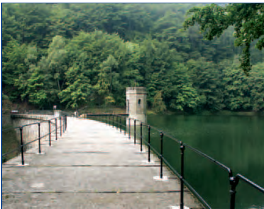
Povodí Ohře - vodní dílo Jezeří
