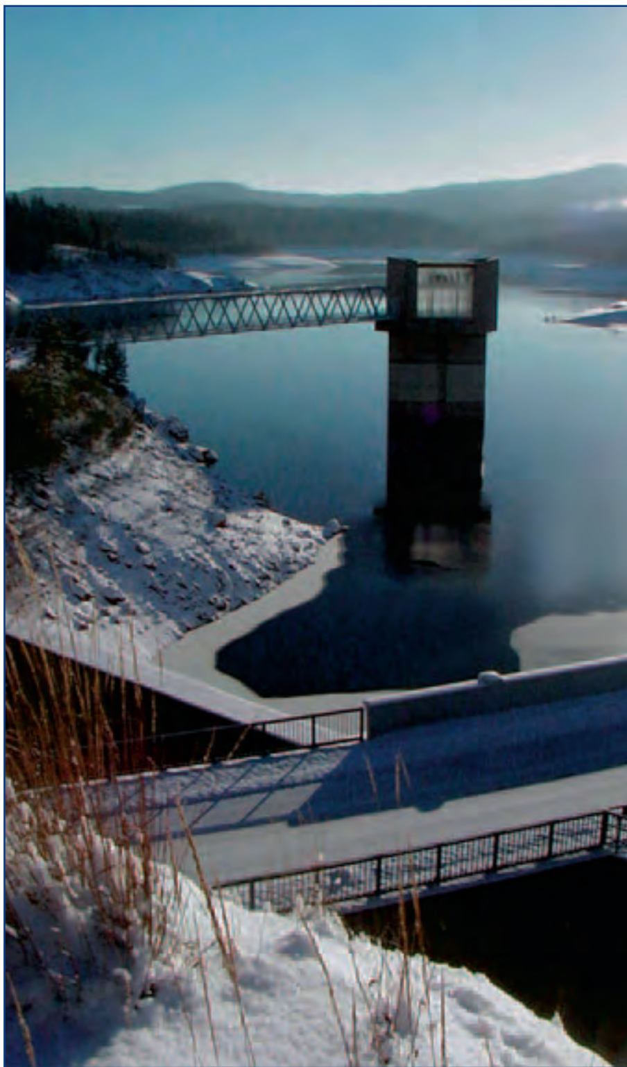
Povodí Ohře - vodní dílo Stanovice
