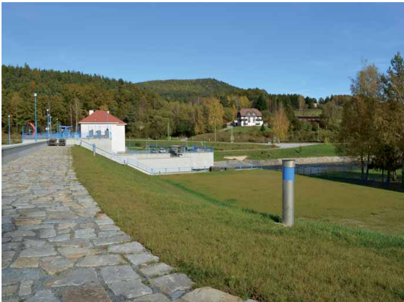
VD Lipno II, zajištění bezpečnosti VD při povodních
