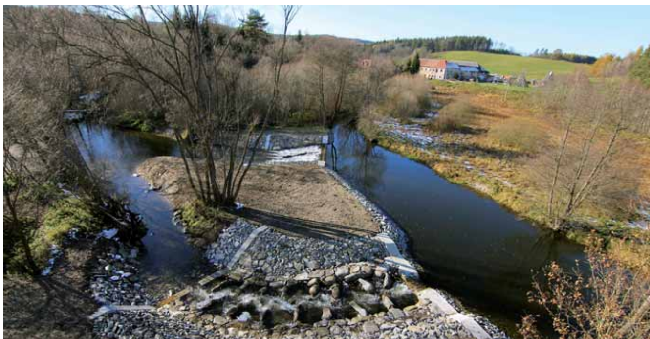
Malše - rekonstrukce jezu Jílek
