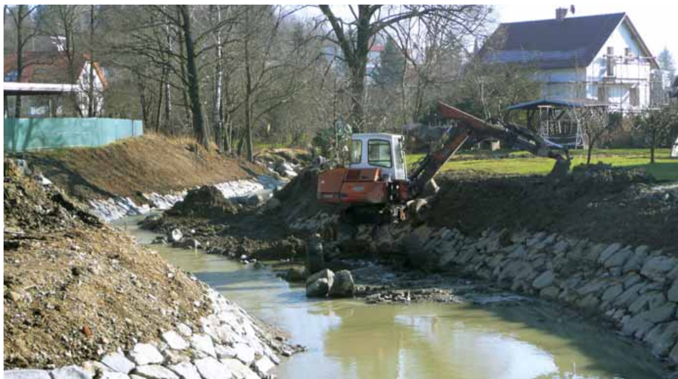
Úprava koryta Ondřejnice, Stará Ves n. Ondřejnicí
