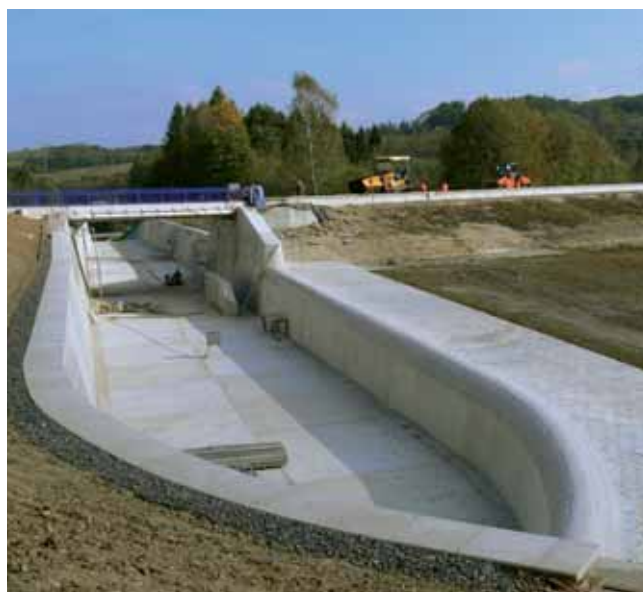
VD Těrlicko - přeliv po rekonstrukci
