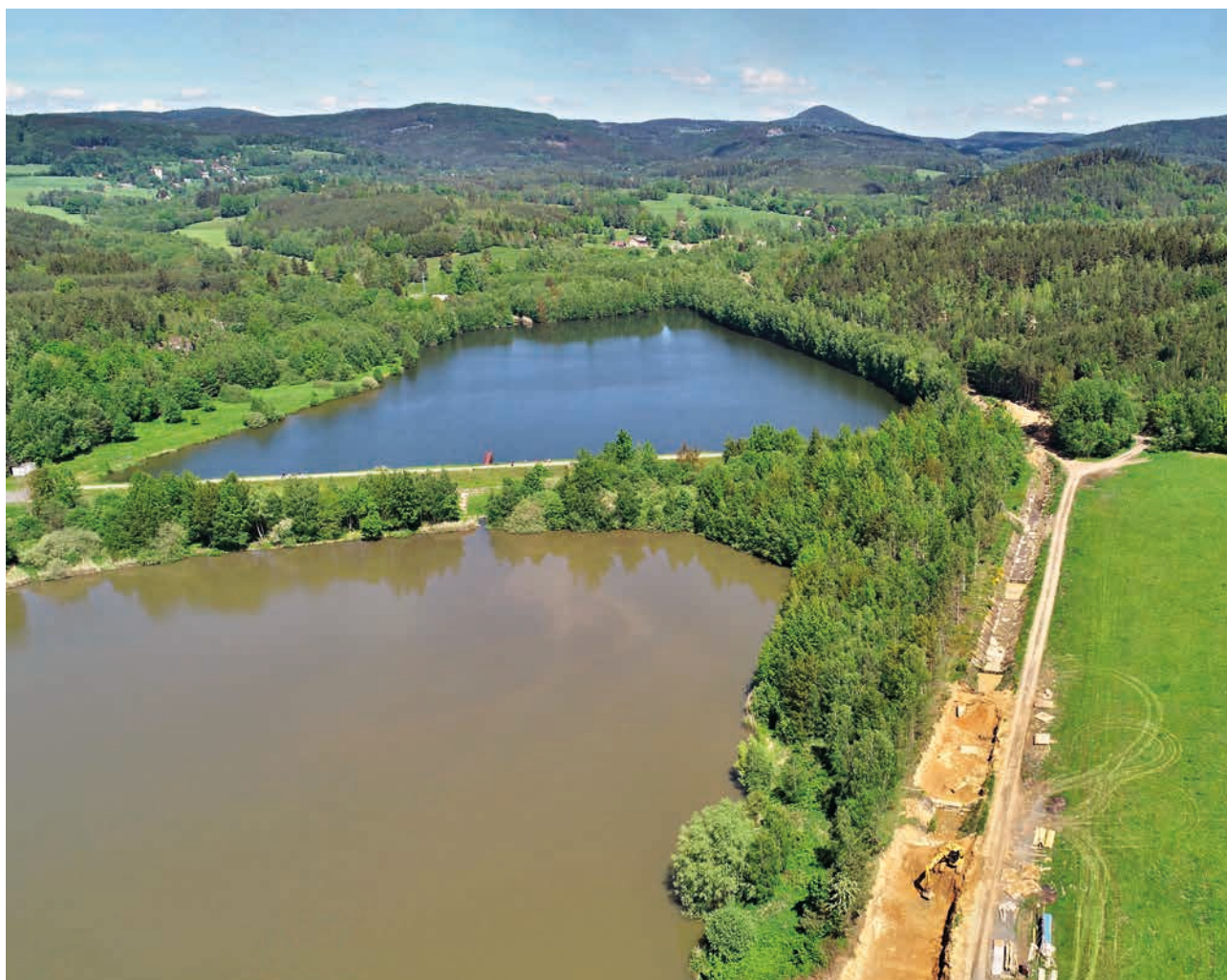
Revitalizace Svitavka (zdroj: Povodí Ohře)
