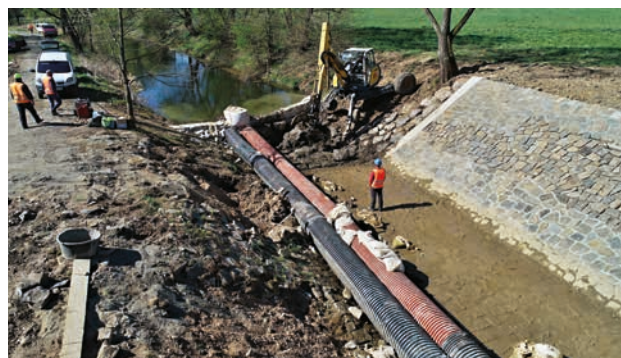
Rekonstrukce limnigrafické stanice Jesenice (zdroj: Povodí Ohře)
