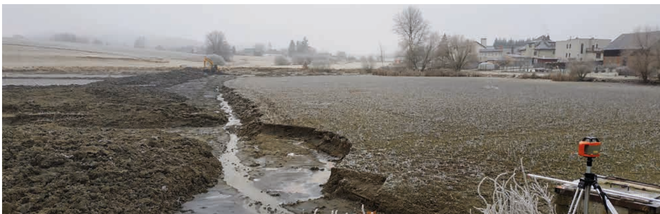
MVN Lužnice, odstranění sedimentů z nádrže (zdroj: Povodí Vltavy)
