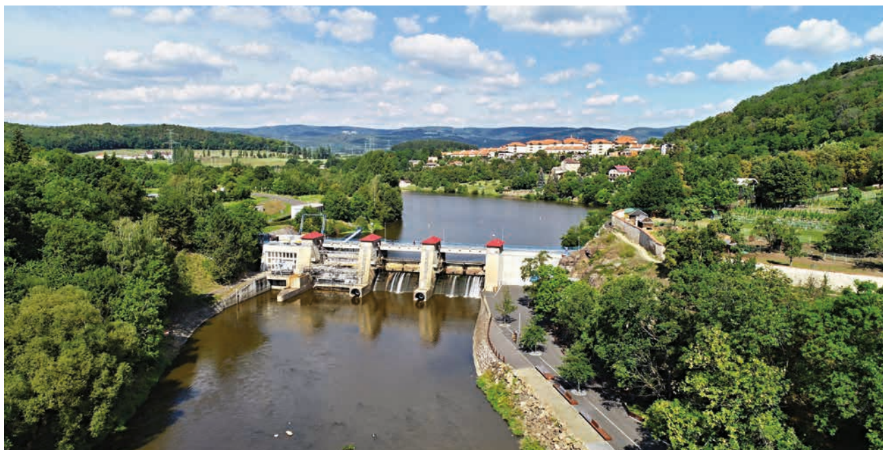
Revitalizace VD Kadaň (zdroj: Povodí Ohře)
