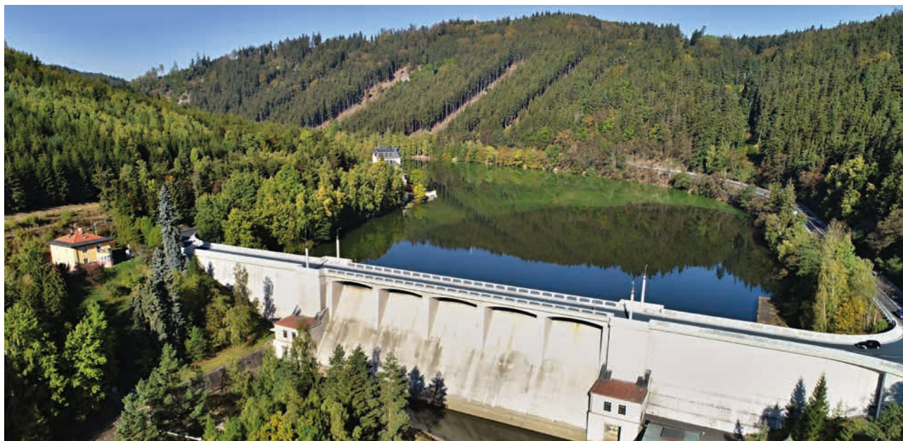
VD Březová (zdroj: Povodí Ohře)
