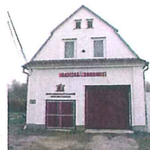
Projekt "Modernizace požární zbrojnice v Nové Vsi v Horách č.p. 2" podal místní Sbor dobrovolných hasičů.
