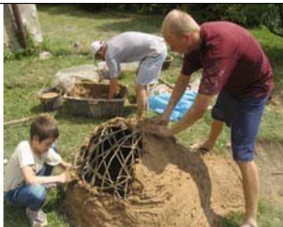
Stavba středověké pece
