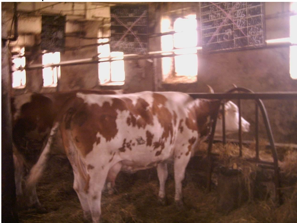
Ustájení krav před rekonstrukcí kravína
