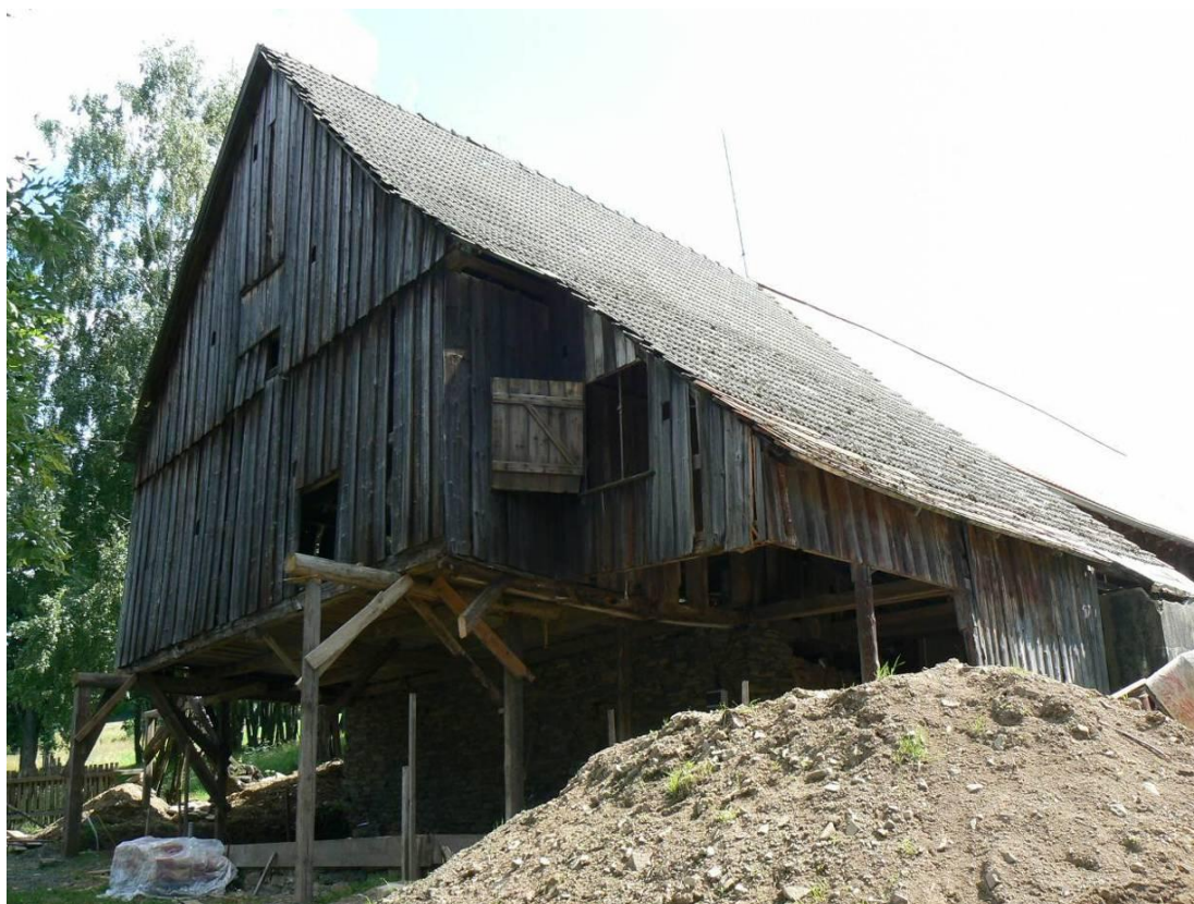
Stav objektu sýrárny v průběhu rekonstrukce 1
