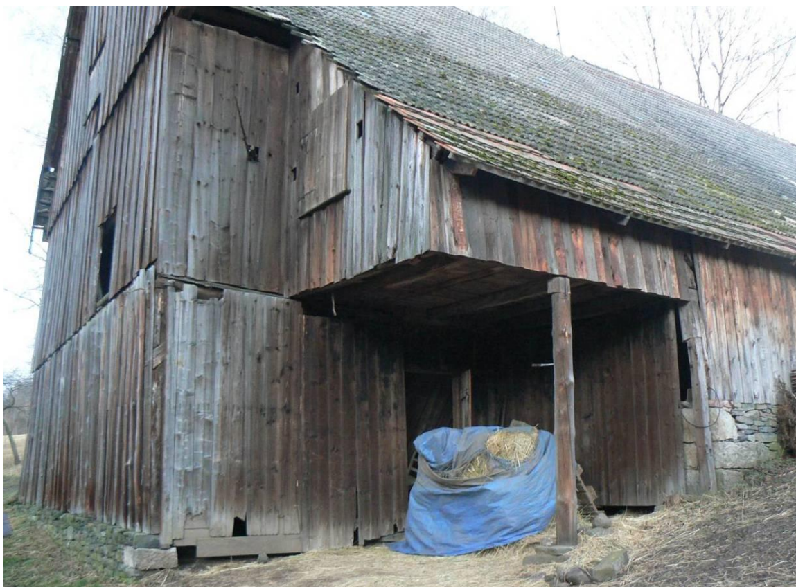
Stav objektu sýrárny před rekonstrukcí 1
