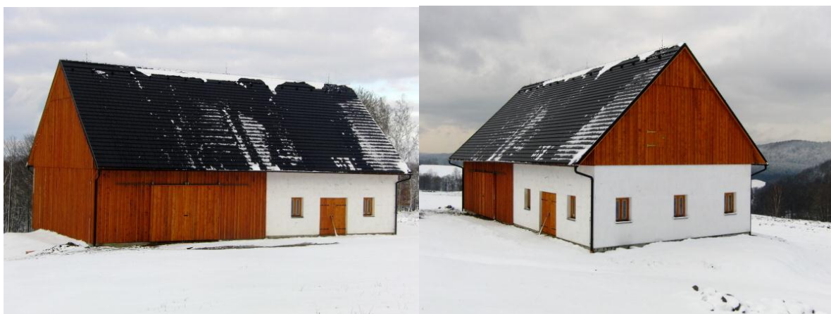
Konečná fáze stavby stodoly na uskladnění krmiv
