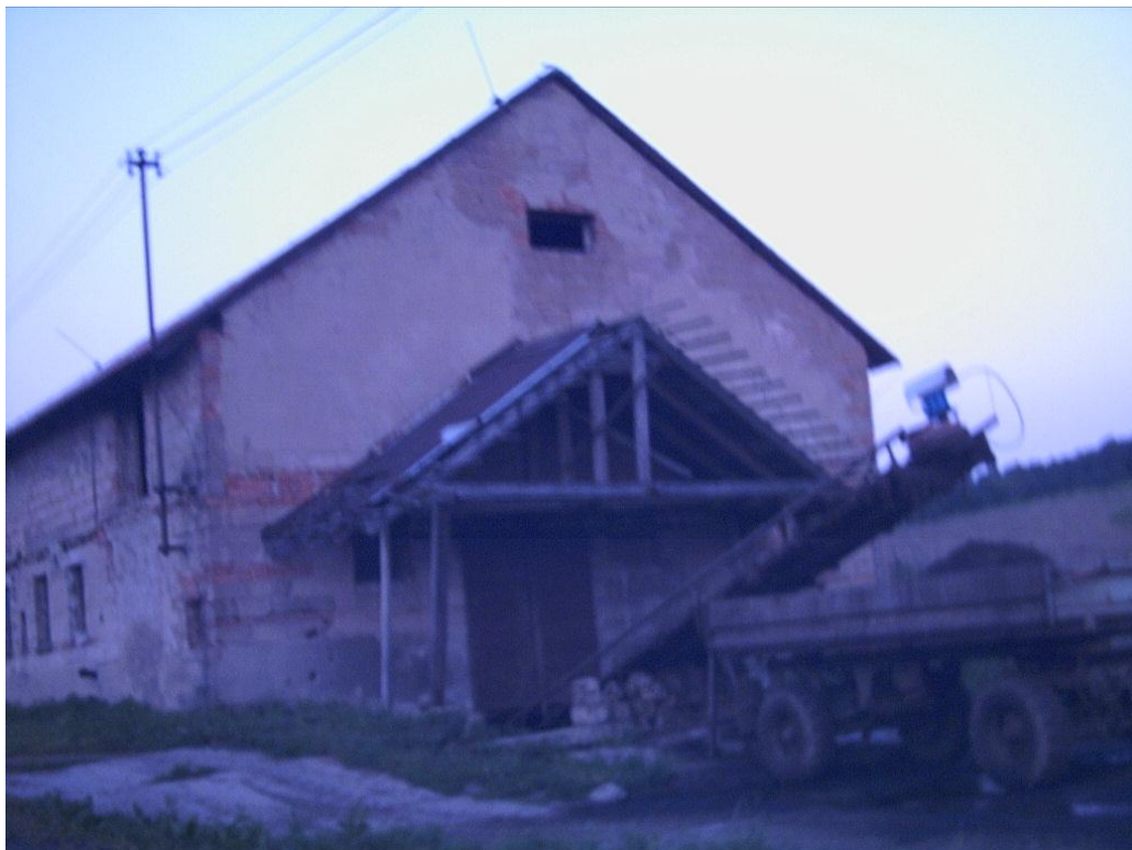
Hnojná koncovka před rekonstrukcí
