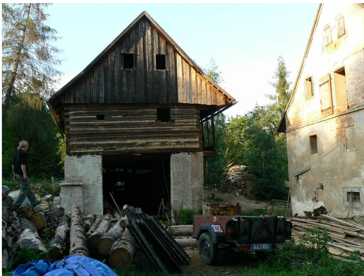
Stav objektu špýcharu v období rekonstrukce, přípravné práce na zpevnění venkovní plochy
