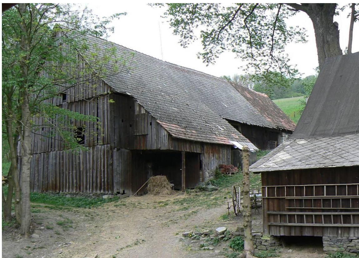
Stav objektu sýrárny před rekonstrukcí 2
