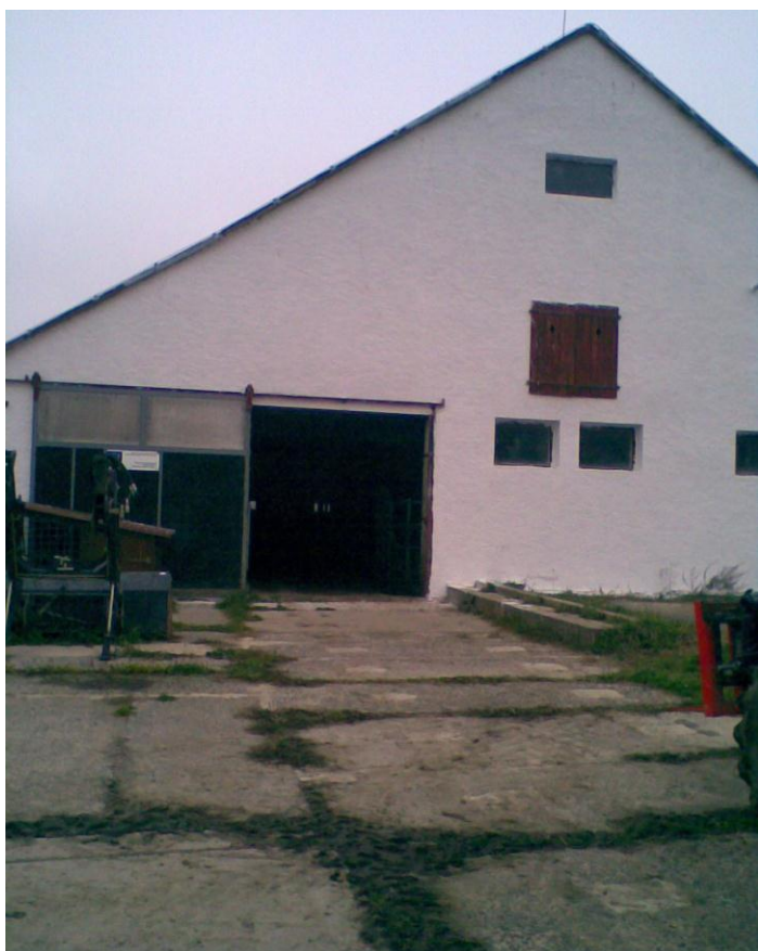
Kravin po rekonstrukci
