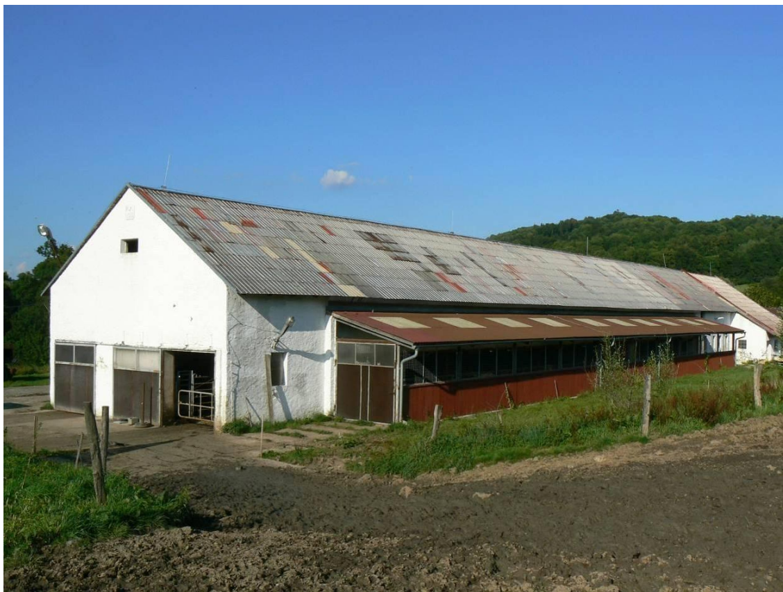
Kravin po rekonstrukci 3
