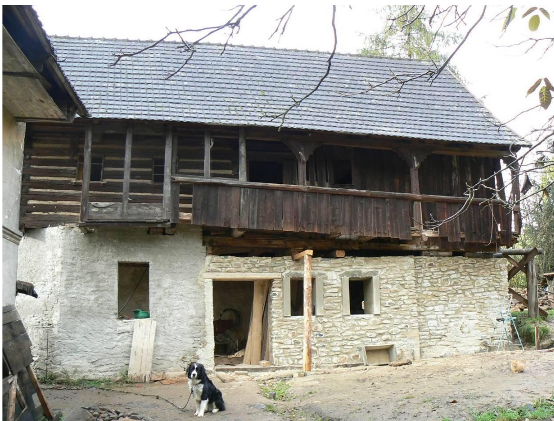
Objekt špýcharu po první fázi rekonstrukce
