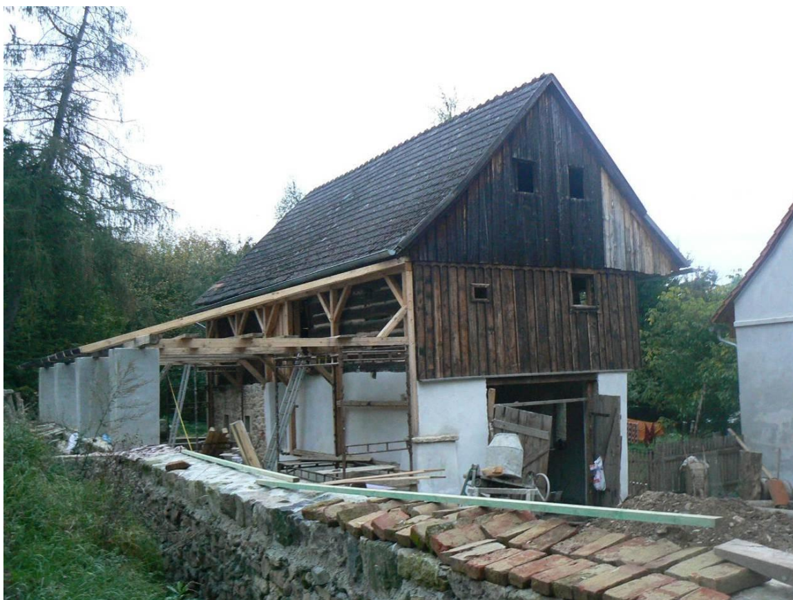
Špýchar v průběhu rekonstrukce
