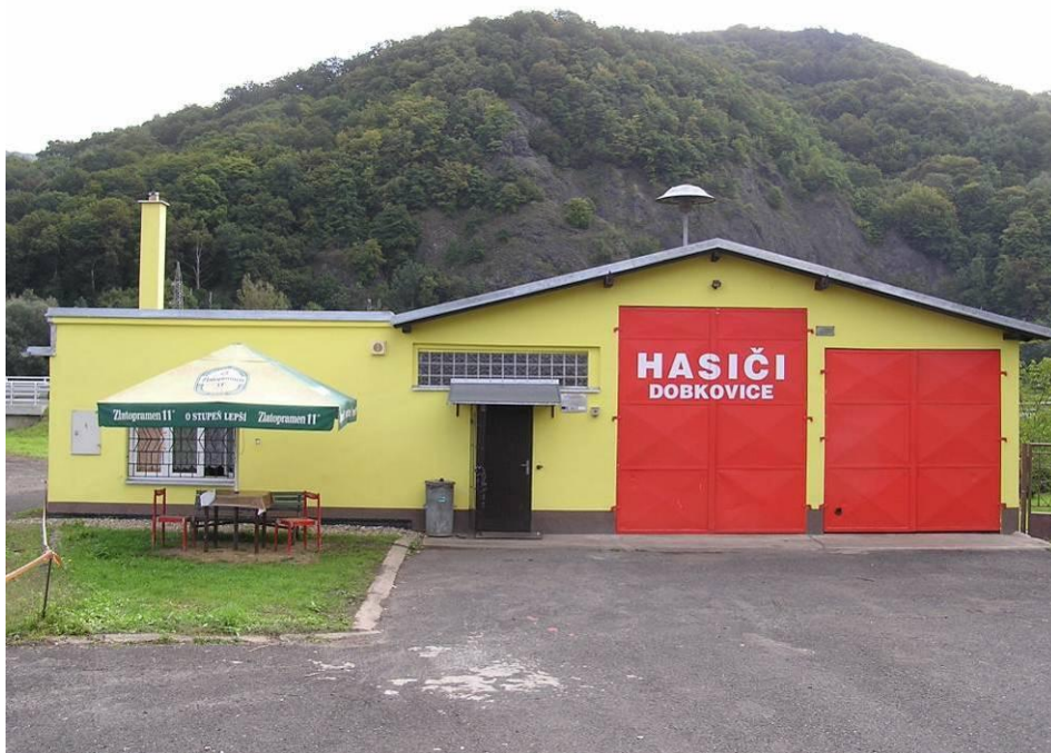
Dobkovická hasičská zbrojnice po rekonstrukci
