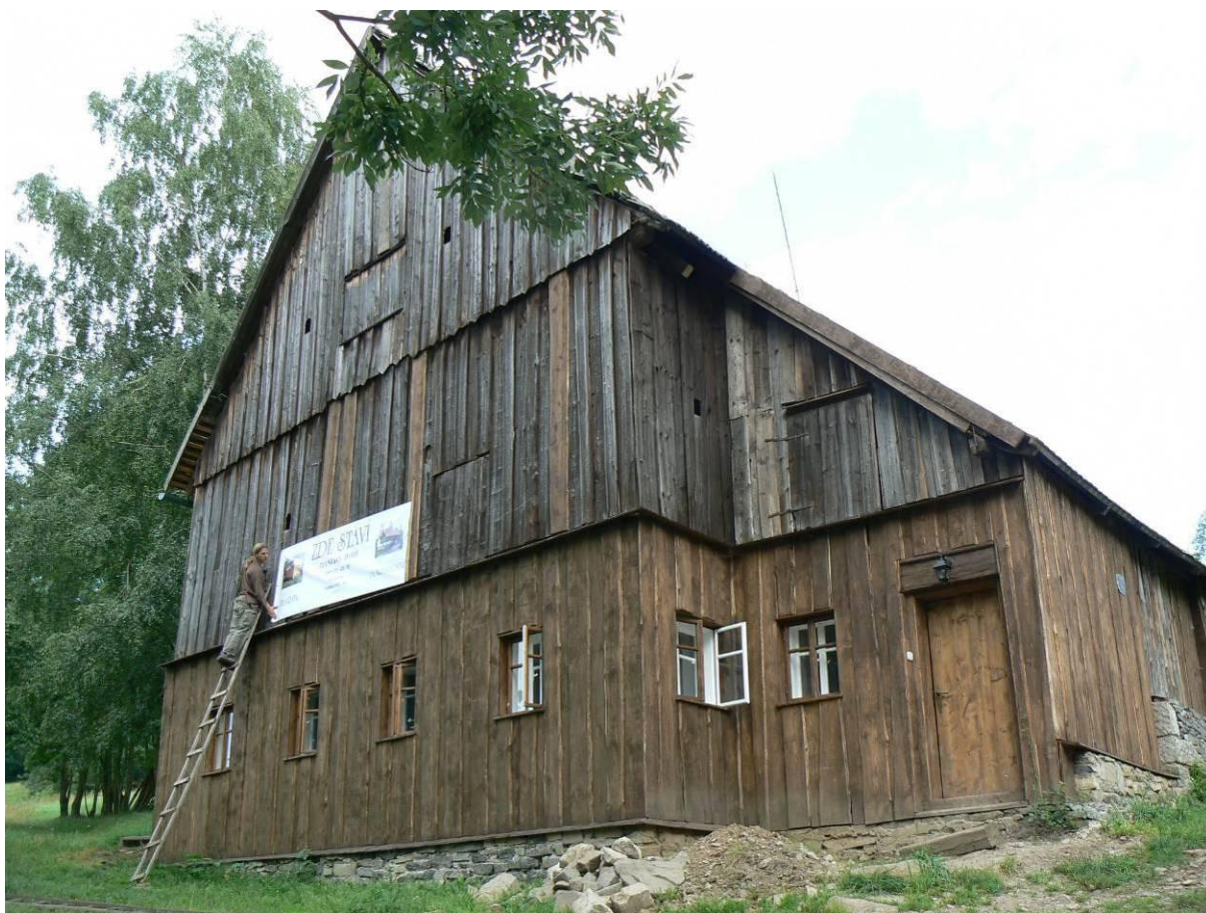
Stav objektu sýrárny po rekonstrukci
