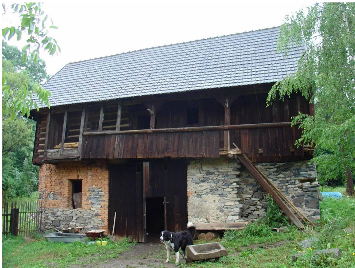
Stav objektu špýcharu před rekonstrukcí 1
