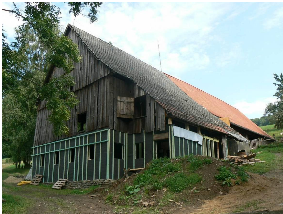
Stav objektu sýrárny v průběhu rekonstrukce 2
