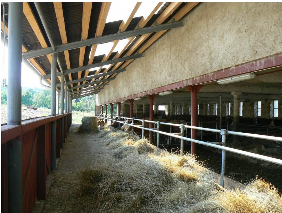
Kravin po rekonstrukci 2
