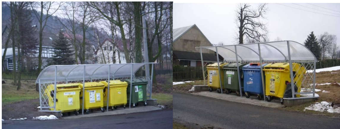
Vybudovaná stání pro kontejnery v obci Tisá
