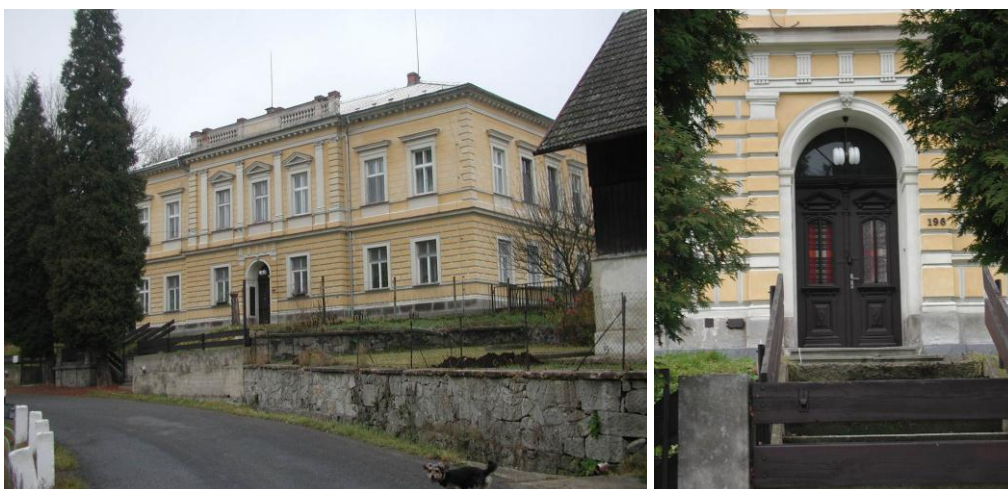
Objekt bývalé školy
