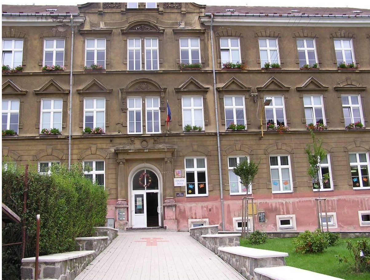
Výměna oken v budově ZŠ a MŠ Petrovice – po skončení I. Etapy
