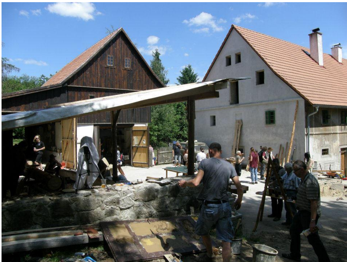
Dokončený objekt špýcharu a zpevněné venkovní plochy
