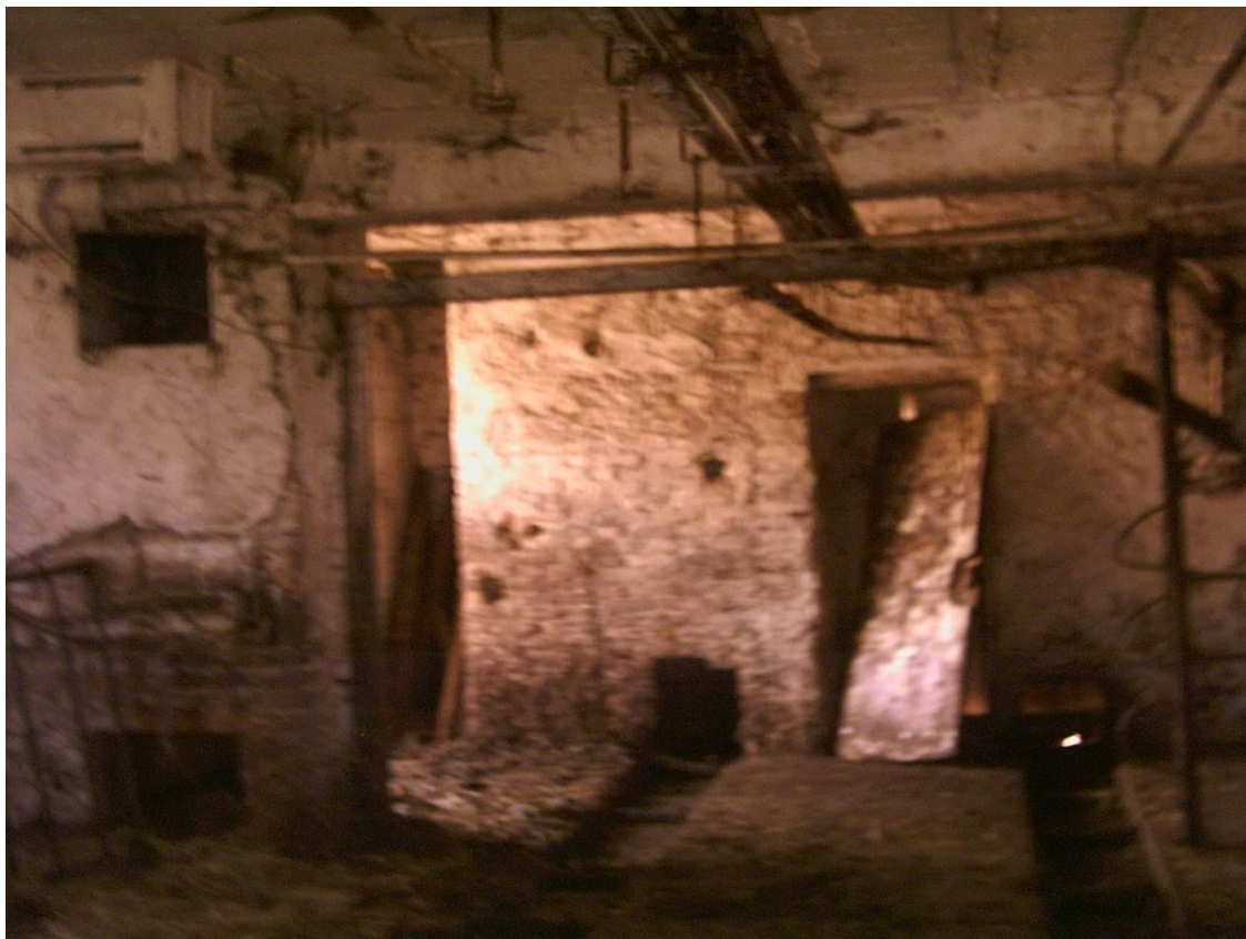
Stav kravína před rekonstrukcí
