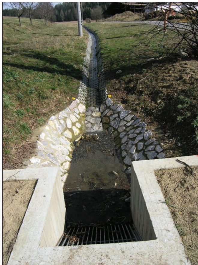
Vtokový objekt – staničení km 0,000
