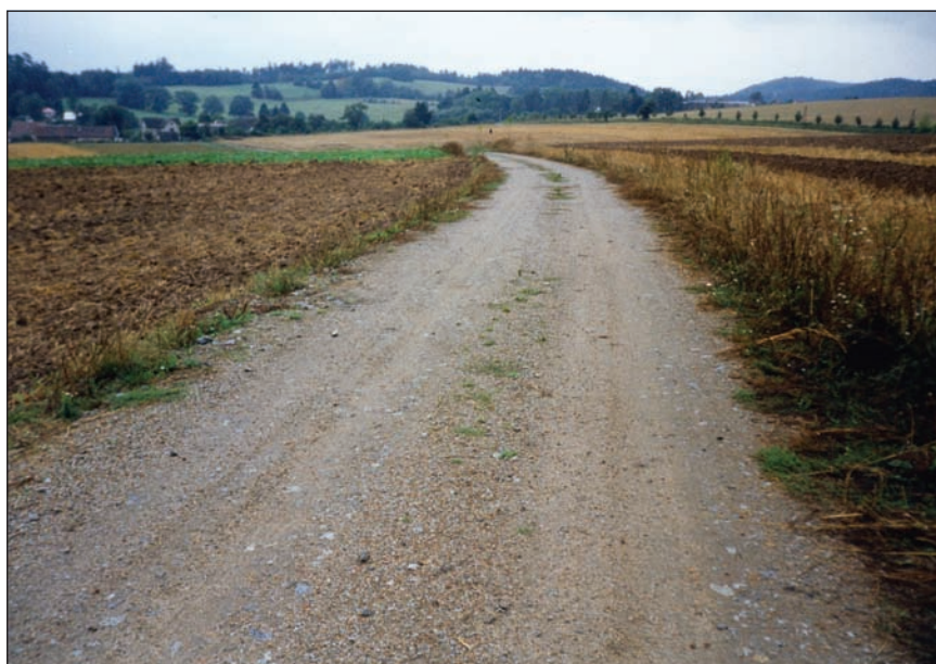
Vedlejší polní cesta se štěrkovým krytem VPC 4/30 po dvou letech provozu (okres Praha-východ)
