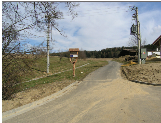
Polní cesta C3 v k. ú. Valchov – staničení km 0,000
