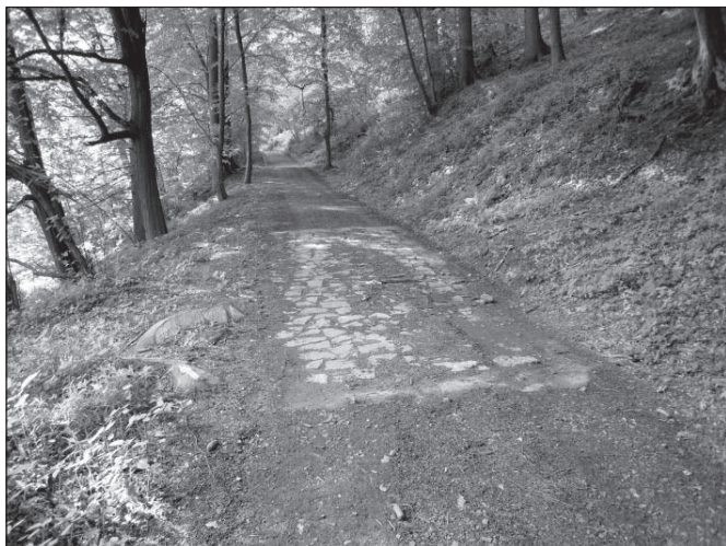
Foto č. 6 – pohled na povrchové převedení vody přes cestu H2 v lesním úseku
