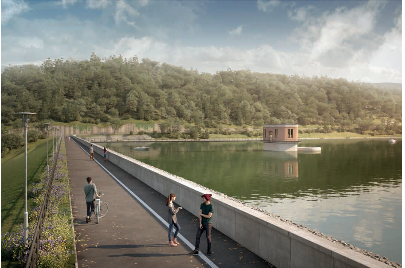
The crown of a dam of water reservoir Koruna hráze vodní nádrže
