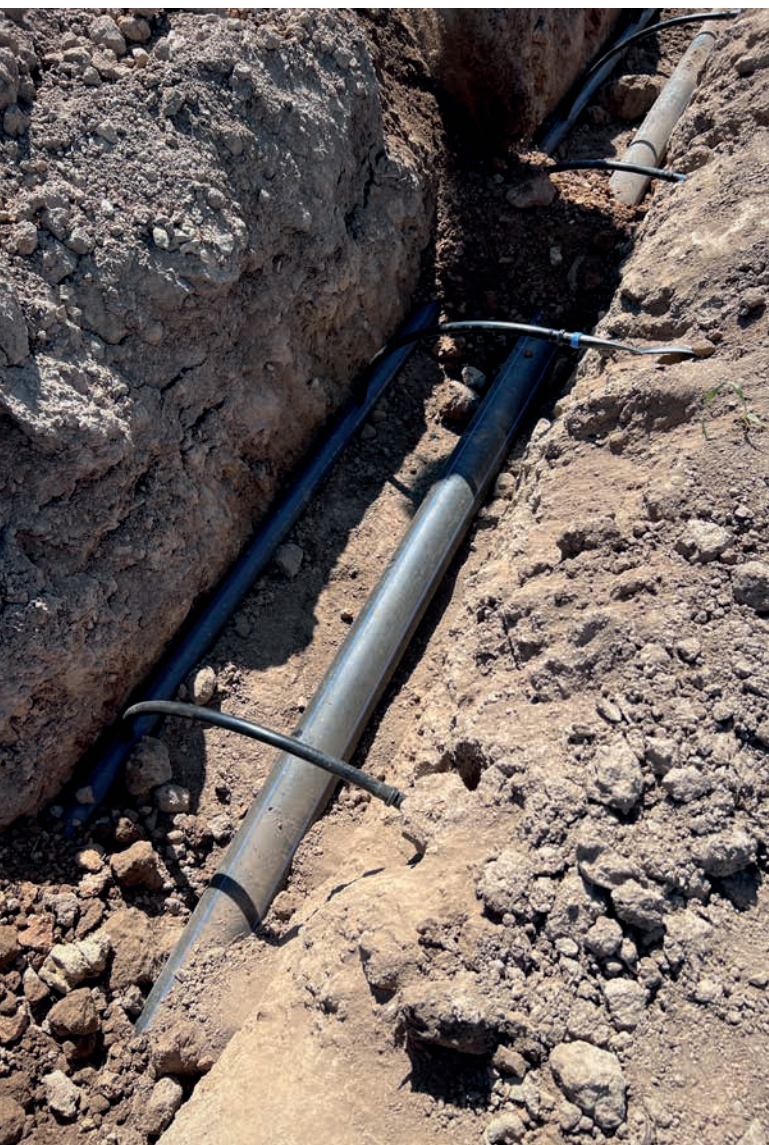
Installation of the Netafim underground drip irrigation system Realizace podzemní kapkové závlahy Netafim
