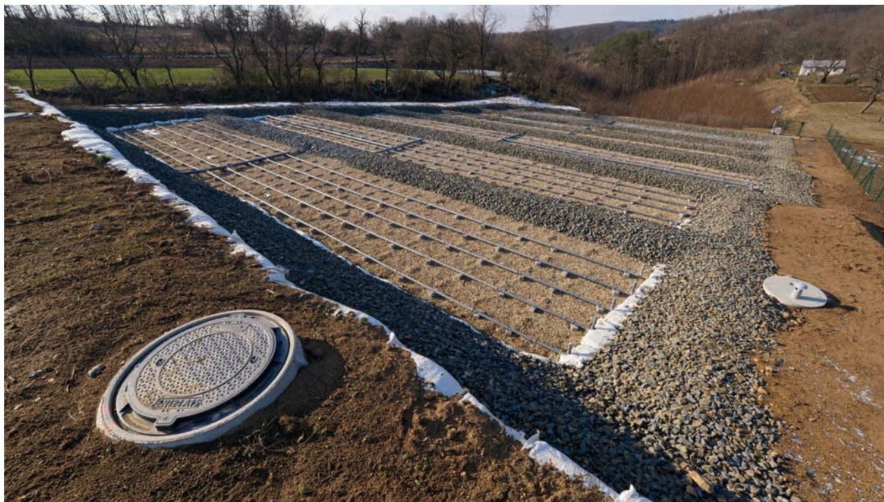
Obec Hlína – odkanalizování a výstavba nové ČOV – spolufinancováno z dotačních prostředků MZe ve výši 24,580 mil. Kč
