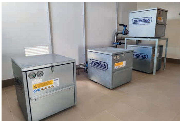
Kanalizace a ČOV Ketkovice – Čučice – spolufinancováno z dotačních prostředků MZe ve výši 41,477 mil. Kč
