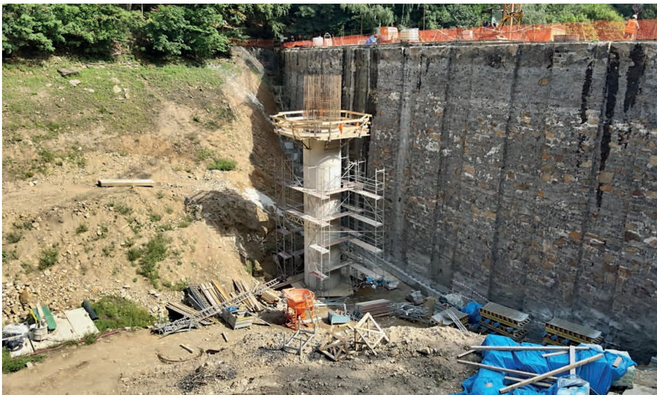
VD Jezeří – rekonstrukce, srpen 2023 (zdroj: Povodí Ohře)
