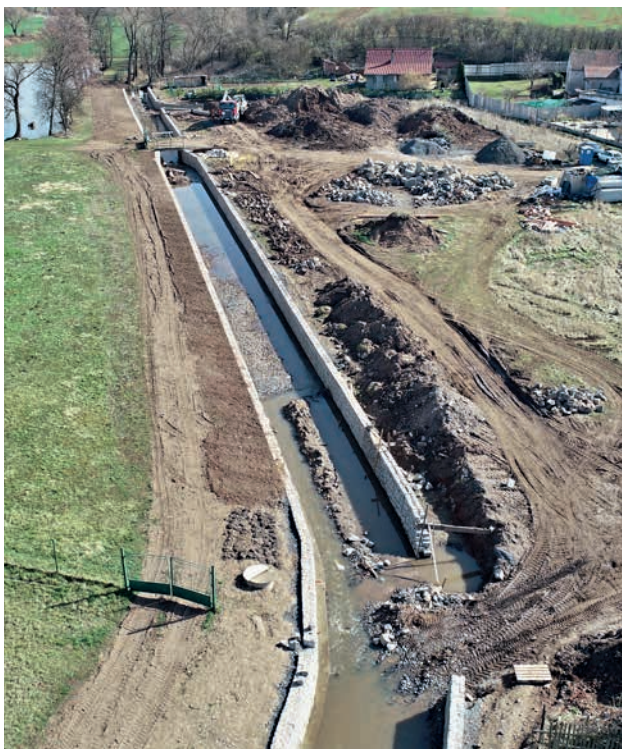
Mlýnecký potok – revitalizace (zdroj: Povodí Ohře)
