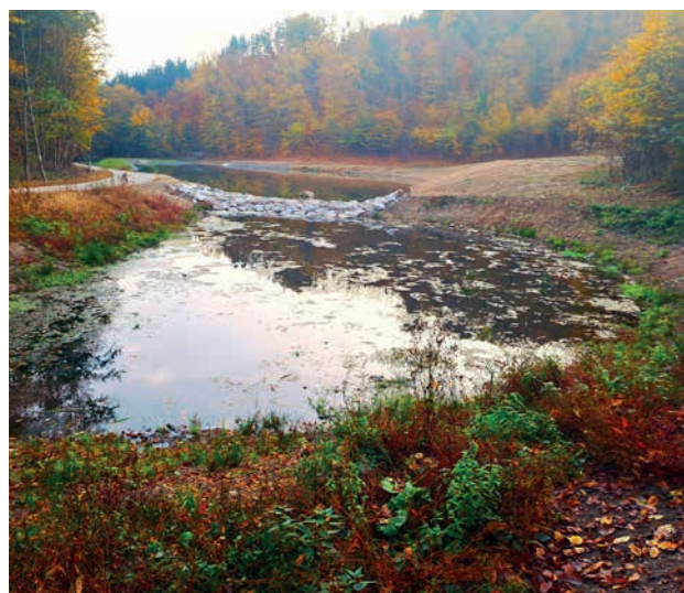
Soustava nádrží Omice – Rosice u Brna (zdroj: LČR)
