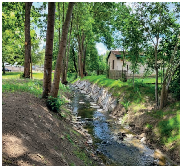
Dobřešovický potok, stabilizace toku (zdroj: Povodí Vltavy)
