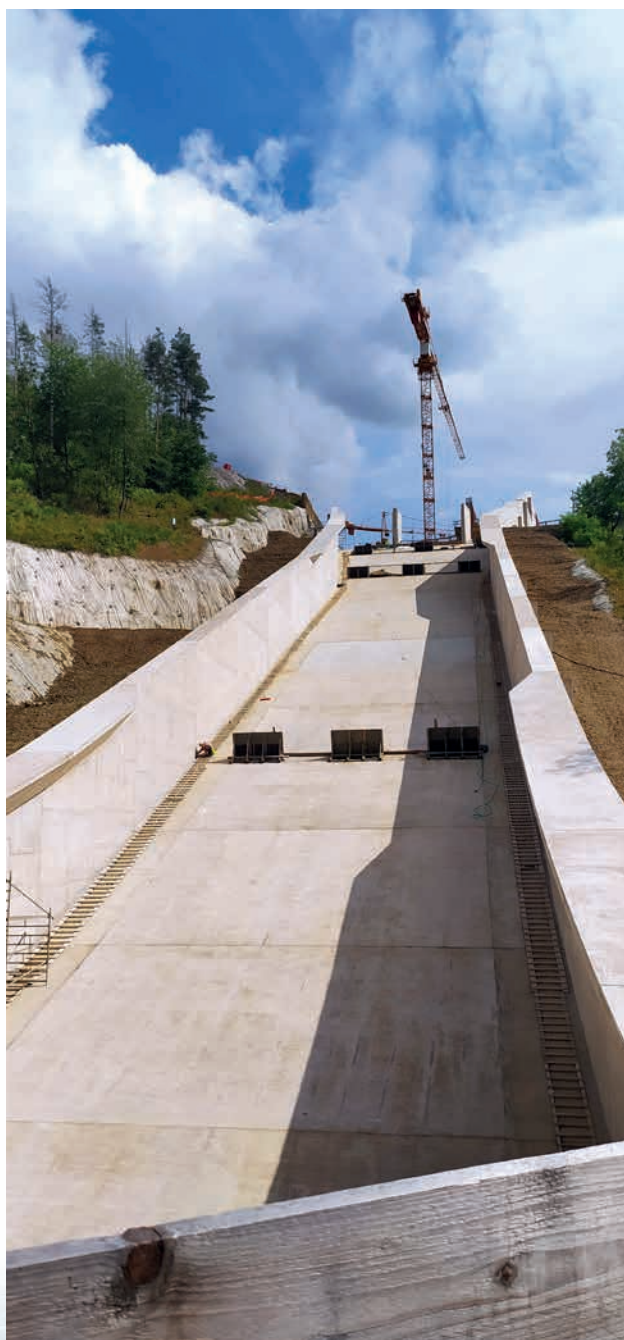
Rekonstrukce skluzu Orlík (autor: Hubalová Petra)
