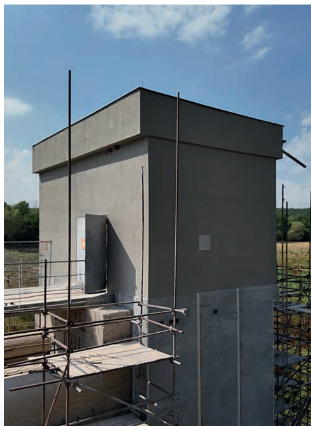
VD Vidhostice – rekonstrukce (zdroj: Povodí Ohře)
