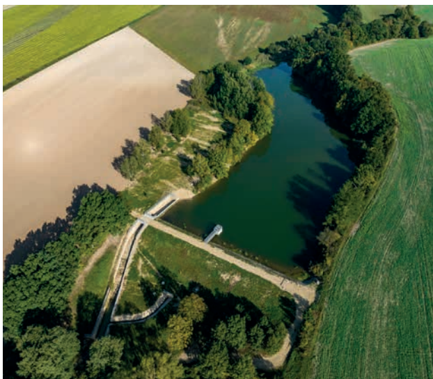
MVN Vlčkovice po obnově (zdroj: Povodí Labe)
