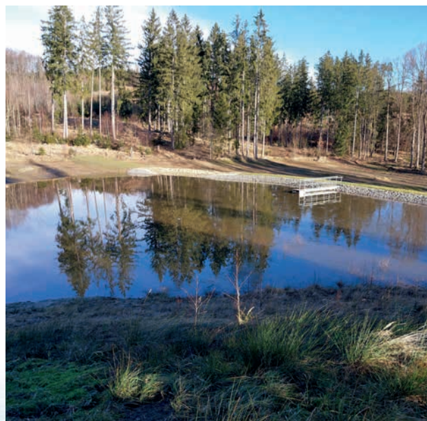
VN na přítoku řeky Třebánky – Prachaticko (zdroj: LČR)
