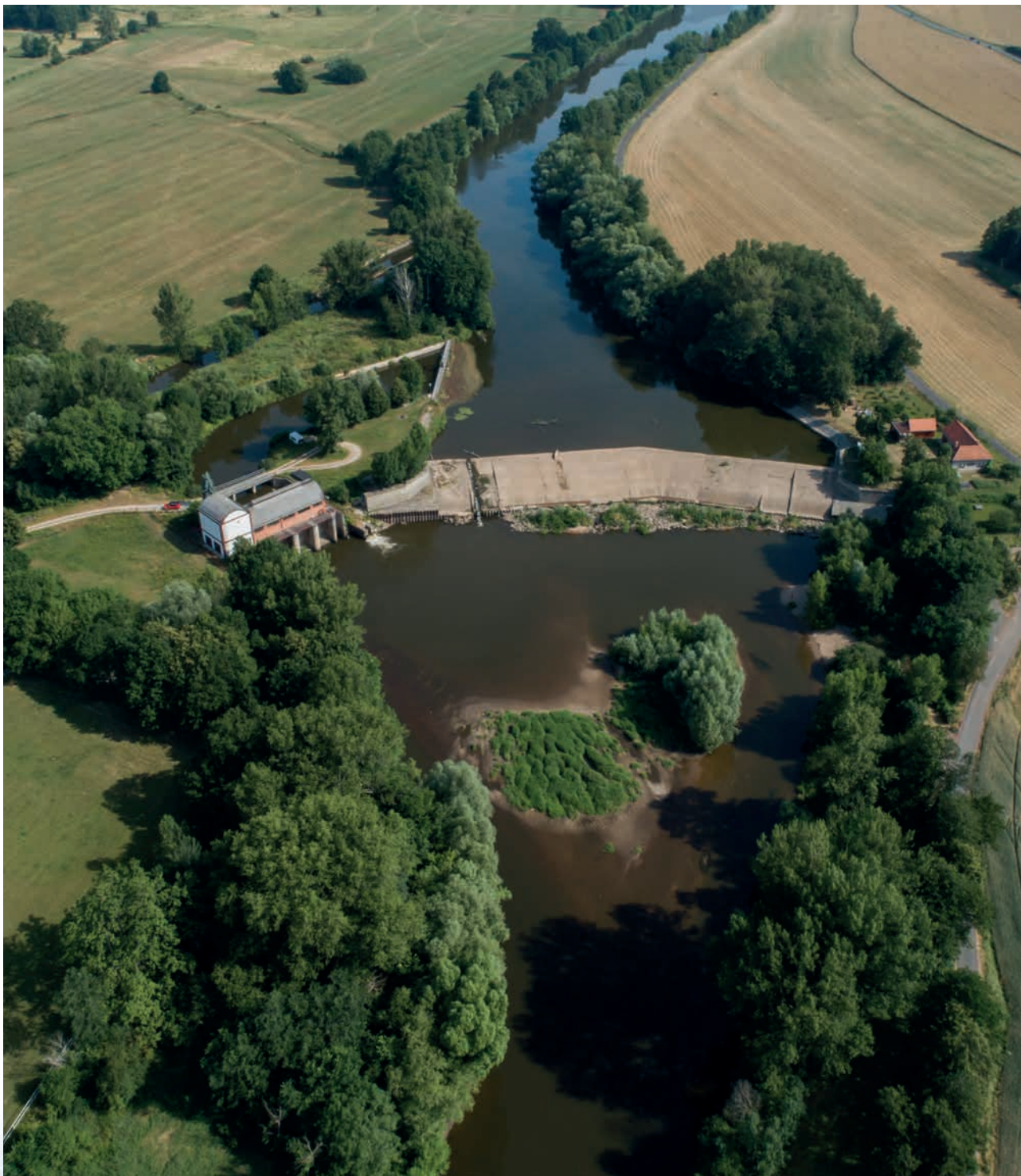
Jez Opatovice nad Labem (zdroj: Povodí Labe)
