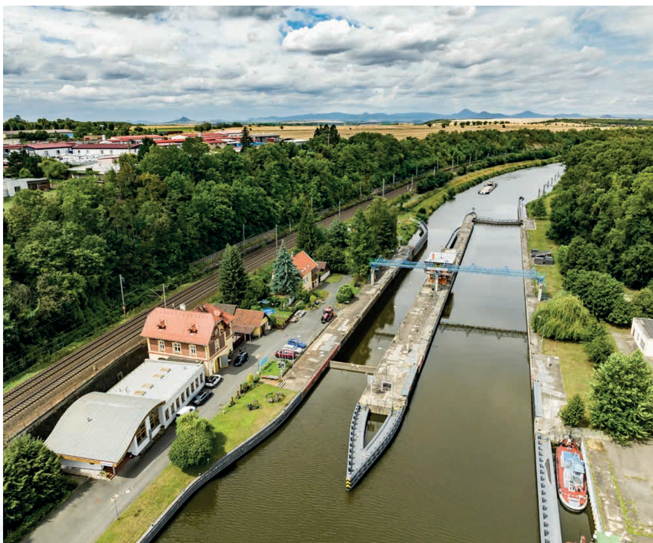
Plavební komory Roudnice nad Labem (zdroj: Povodí Labe)
