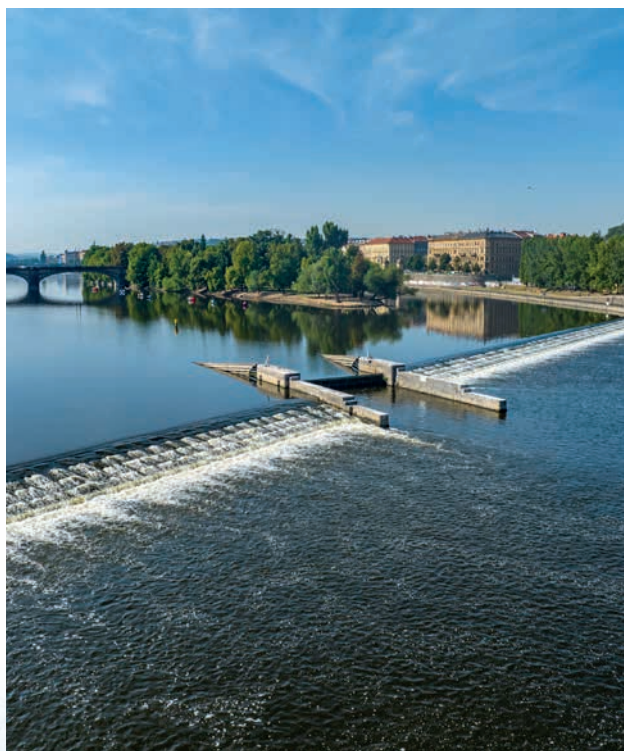
Staroměstský jez po celkové rekonstrukci (zdroj: Povodí Vltavy)
