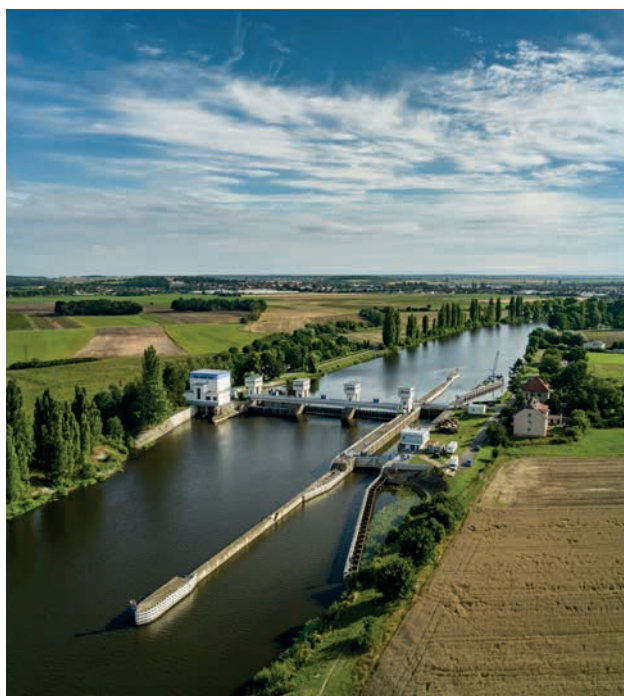
Zdyadlo Lysá nad Labem (zdroj: Povodí Labe)
