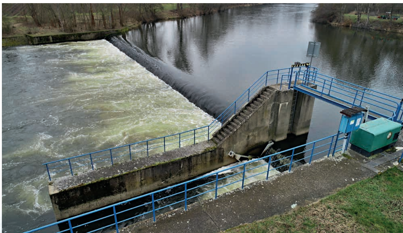
Čerpací stanice Stranná odběrné místo (zdroj: Povodí Ohře)
