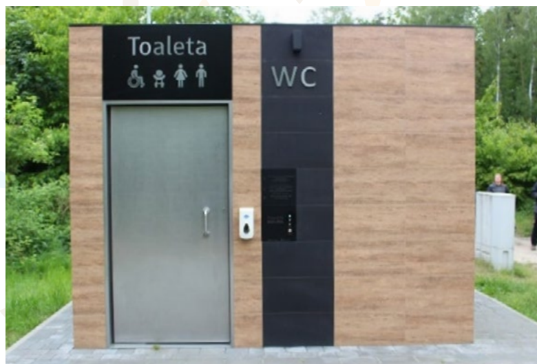
Foto: Toalety jsou nezbytnou součástí a vizitkou. Zdroj: Archiv CSV
