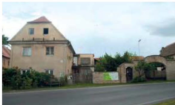
The farmstead of Kryštof Semš, No. 22 in Vrbice village Usedlost Kryštofa Semše č. p. 22, v obci Vrbice
