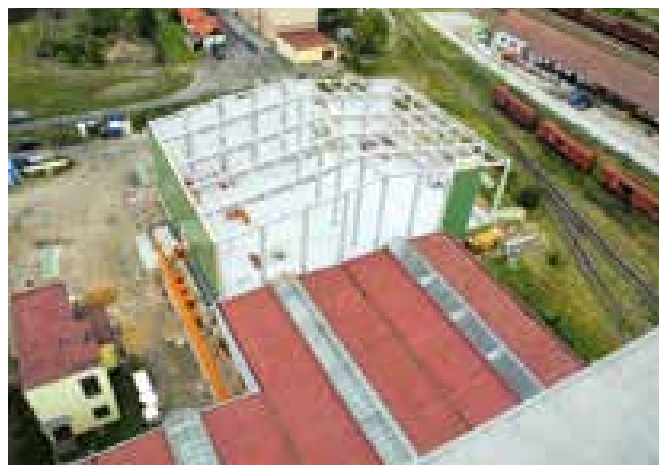
Construction of the new warehouse Výstavba FNS
