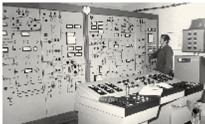
Vilda Modrocki in the control room of the new packing hall Vilda Modrocki na velině NB
