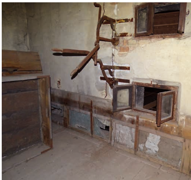
Preserved technology to control lath boxes. Oast kiln. Hříškov (District of Louny) Zachovaná technologie k ovládání lísek. Hvozďová sušárna. Hříškov (okr. Louny)
