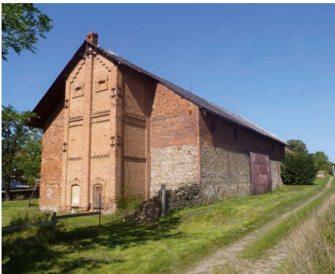
Kiln at Vacanovice farmstead No. 15 (Photographer: Jiří Kaláb) Sušárna u usedlosti č. p. 15, Vacanovice (autor fotografie: Jiří Kaláb)
